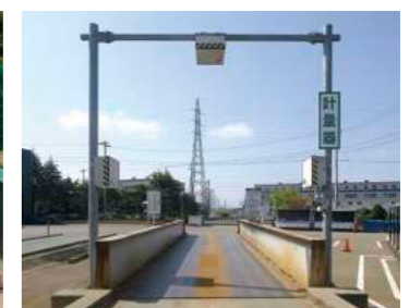
射水RC 80tトラックスケール
