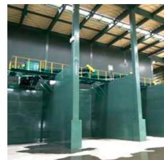
ダスト保管ヤード
