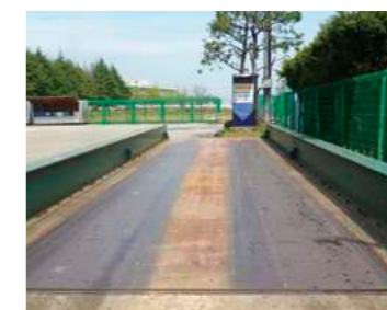
本社 80tトラックスケール
